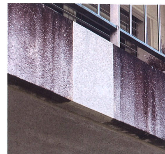
Support après un lavage à la pression et un algicide.
