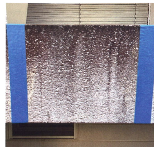
Support infesté de micro-organismes avant nettoyage.
