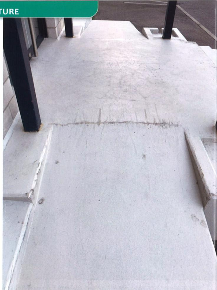
Le carrelage peut être peint. Il nécessite une préparation minutieuse et un fond d'accrochage en résine époxy.
